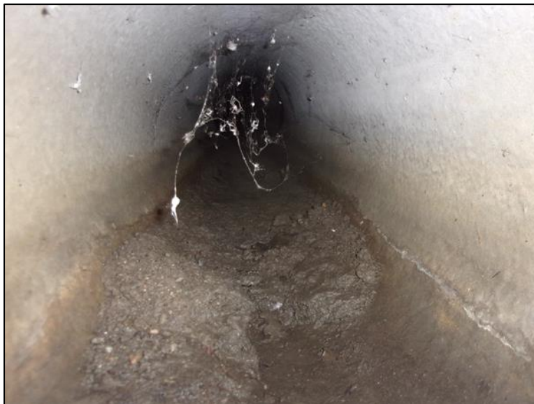
Photo 2 : Vue d'un réseau à curer – Rue de la Mairie (Ø300)
