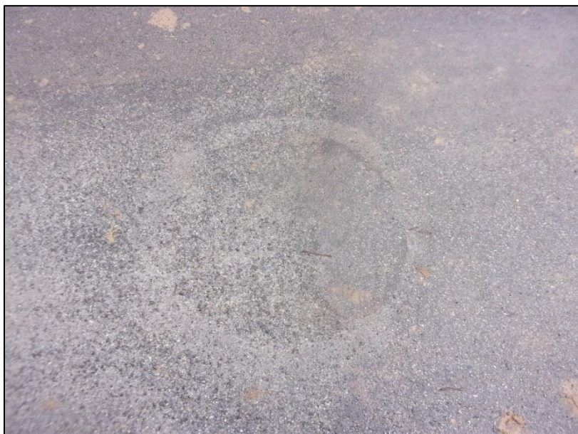
Photo 4 : Vue d'un tampon sous enrobé – Rue de Bellevue
