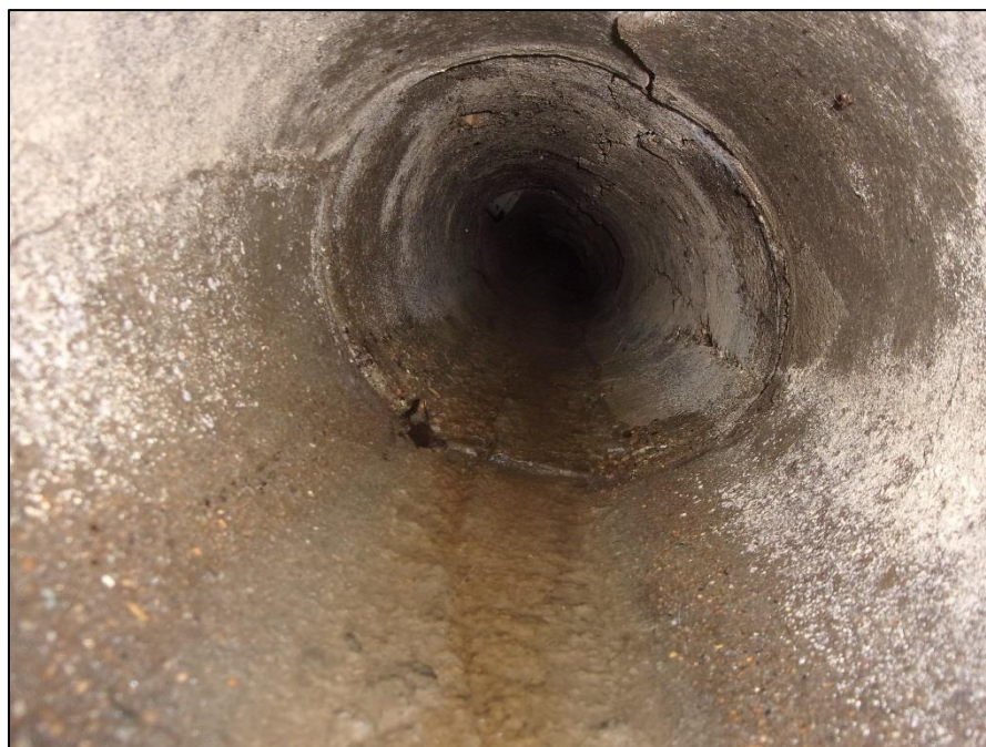
Photo 6 : Réseau Ø300 fissuré
