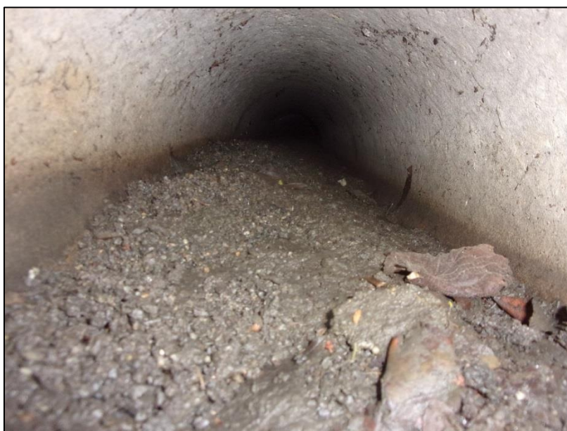
Photo 3 : Vue d'un réseau à curer – Allée des Pins (Ø300)
