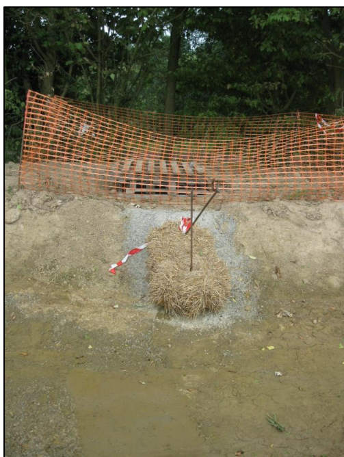
Photo 8 : Emplacement du filtre à particules fines (botte de paille) pendant la phase des travaux au niveau du bassin d'orage
