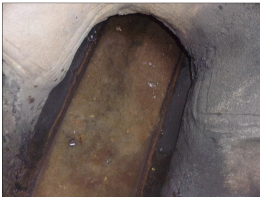
Photo 5 : Vue d'un rejet d'eaux vannes
