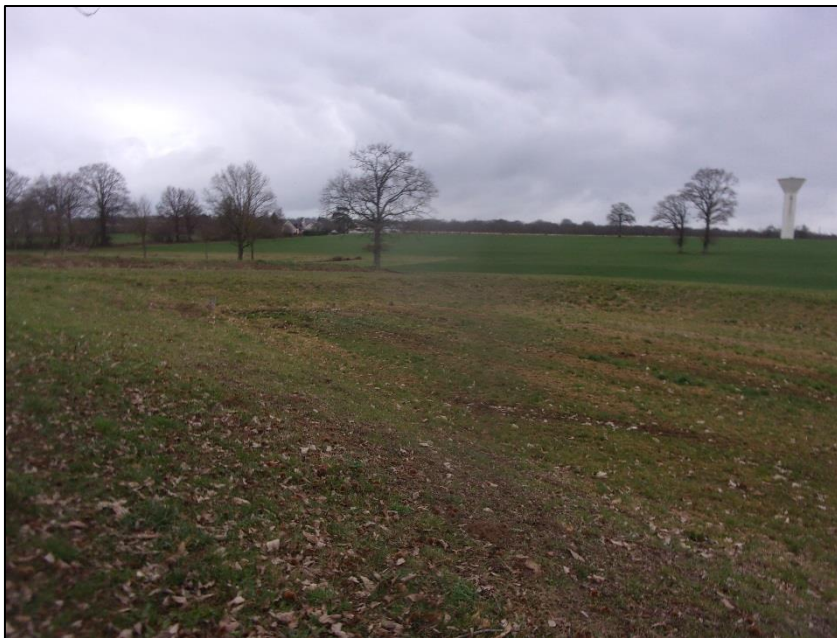
Photo 7 : Vue du bassin d'orage du lotissement de la Croix
