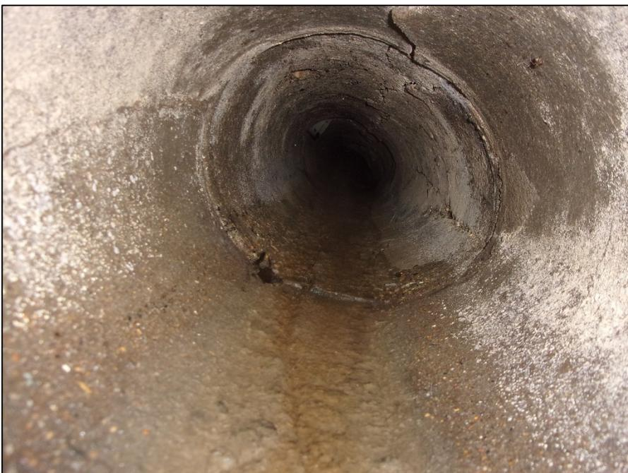
Photo 5 : Réseau Ø300 fissuré
