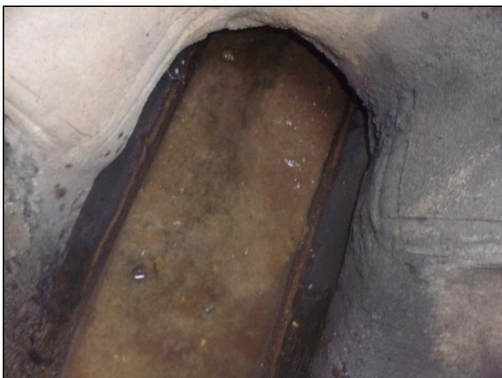
*Photo 4 : Vue d'un rejet d'eaux vannes*
